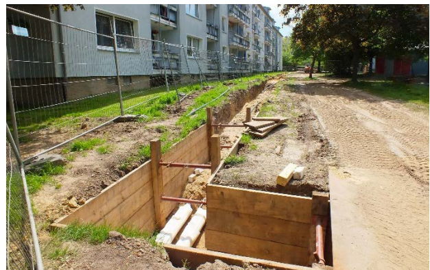
Leitungsbau im Quartier Hildesheim-Drispstedt © gbg Hildesheim
